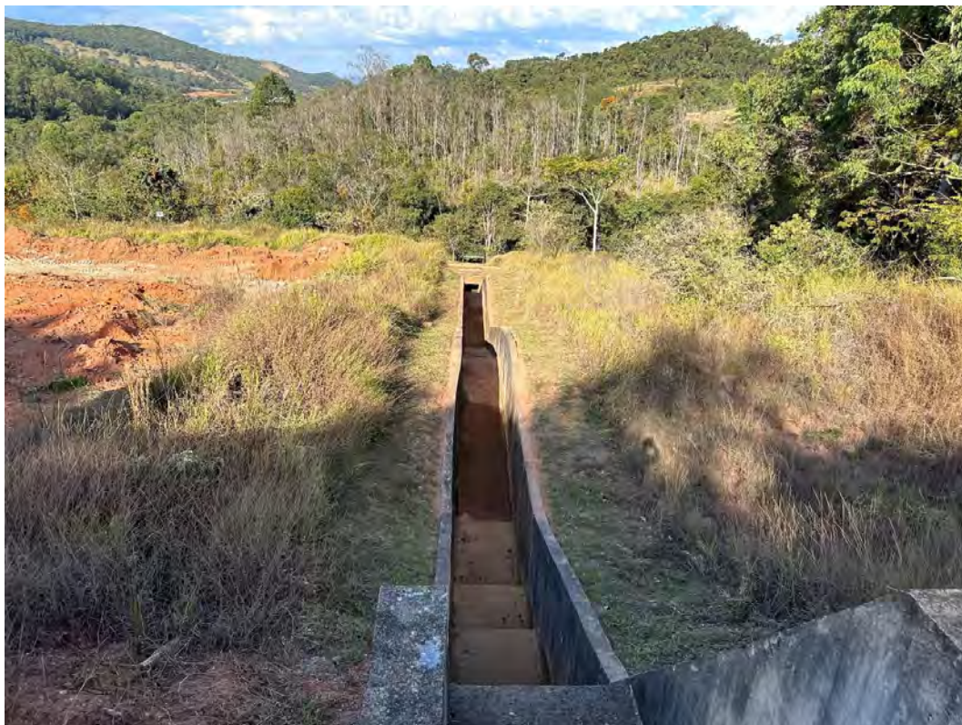
Foto 9 – Descida hidráulica do Canal extravasor de emergência.
