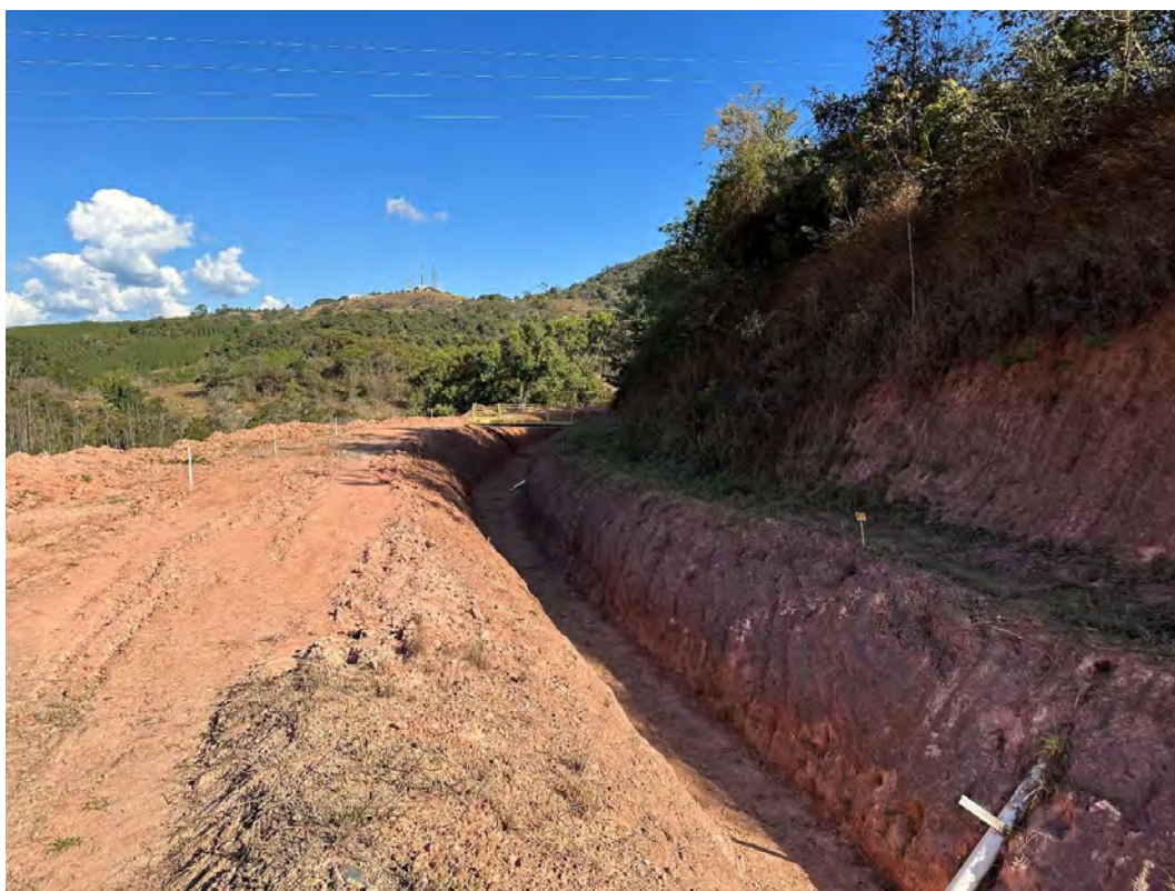
Foto 8 – Canal extravasor de emergência – Detalhe para as atividades de limpeza.
