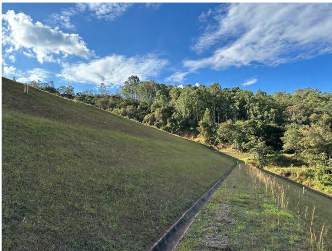
Foto 13 – Talude de jusante – Berma da cota 975 m – Vista para a ombreira esquerda.
