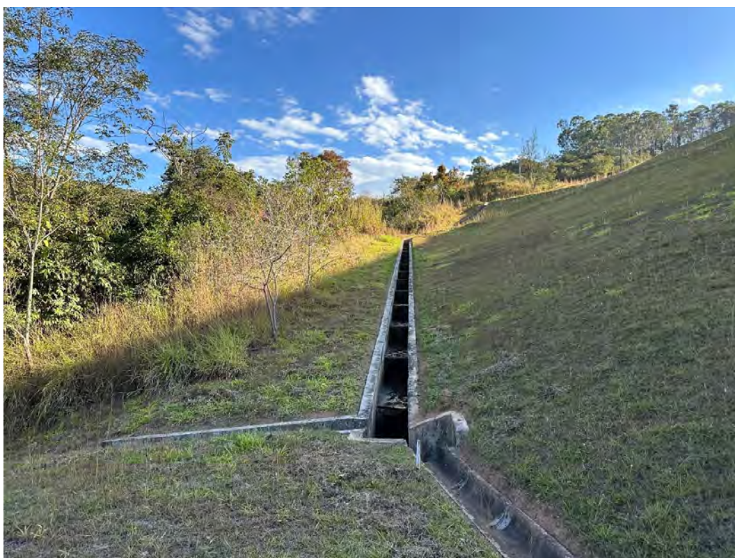
Foto 22 – Canaleta de contato entre o terreno natural e o maciço da barragem – Ombreira direita.
