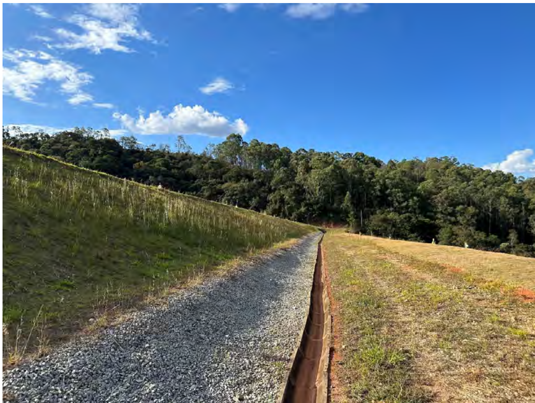
Foto 11 – Talude de jusante – Berma da cota 985 m - Vista para a ombreira esquerda.
