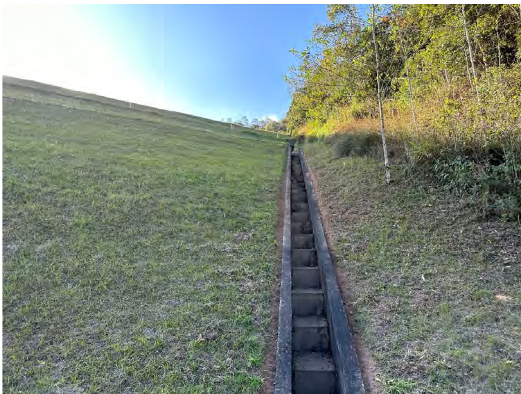
Foto 21 – Canaleta de contato entre o terreno natural e o maciço da barragem – Ombreira esquerda.
