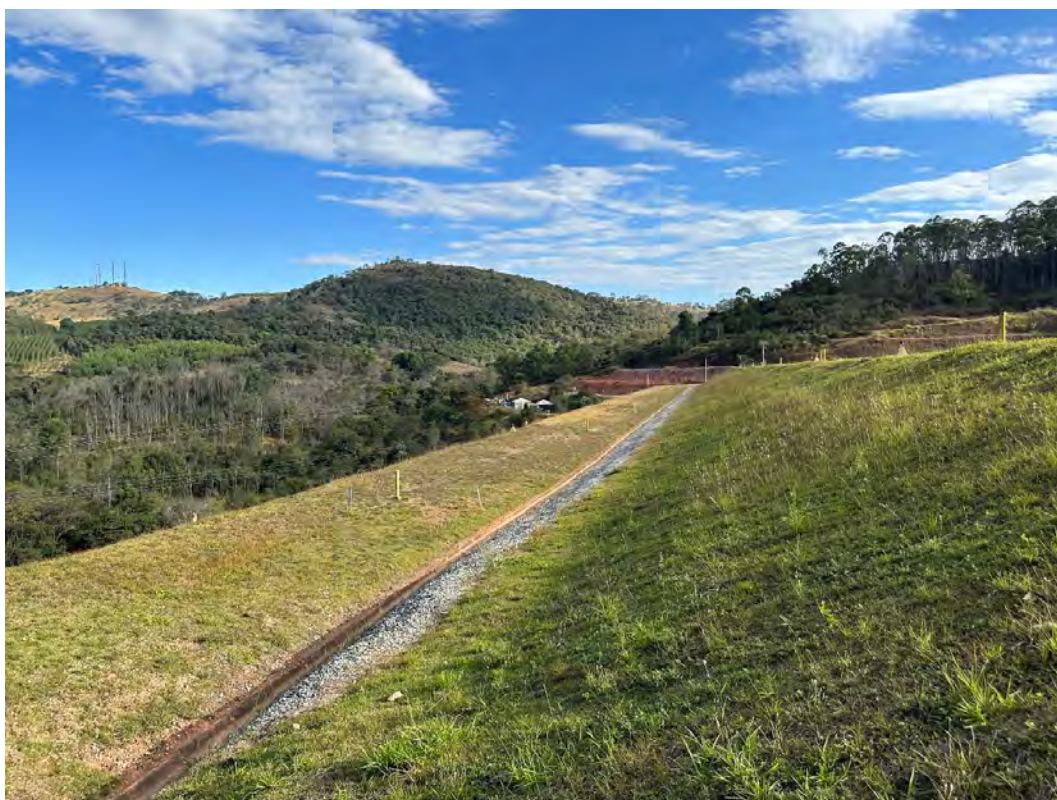
Foto 10 – Talude de jusante entre as cotas 985 e 990 m - Vista para a ombreira direita.
