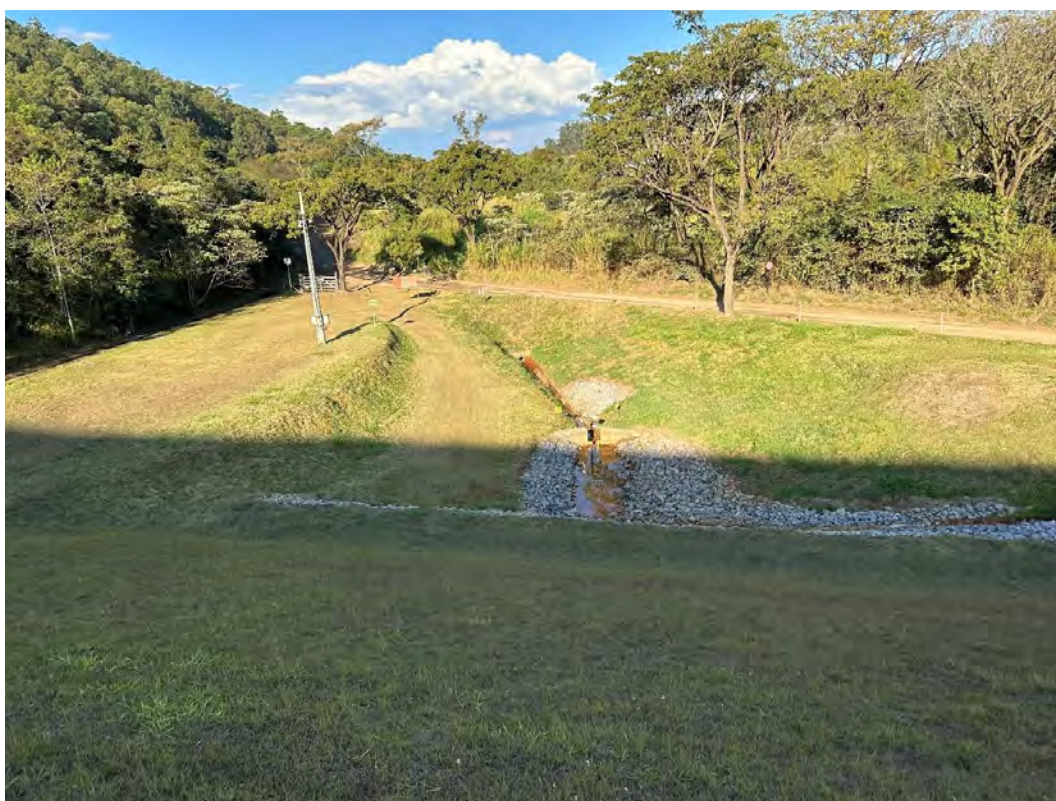
Foto 18 – Talude de jusante – Vista para a área de jusante da barragem.
