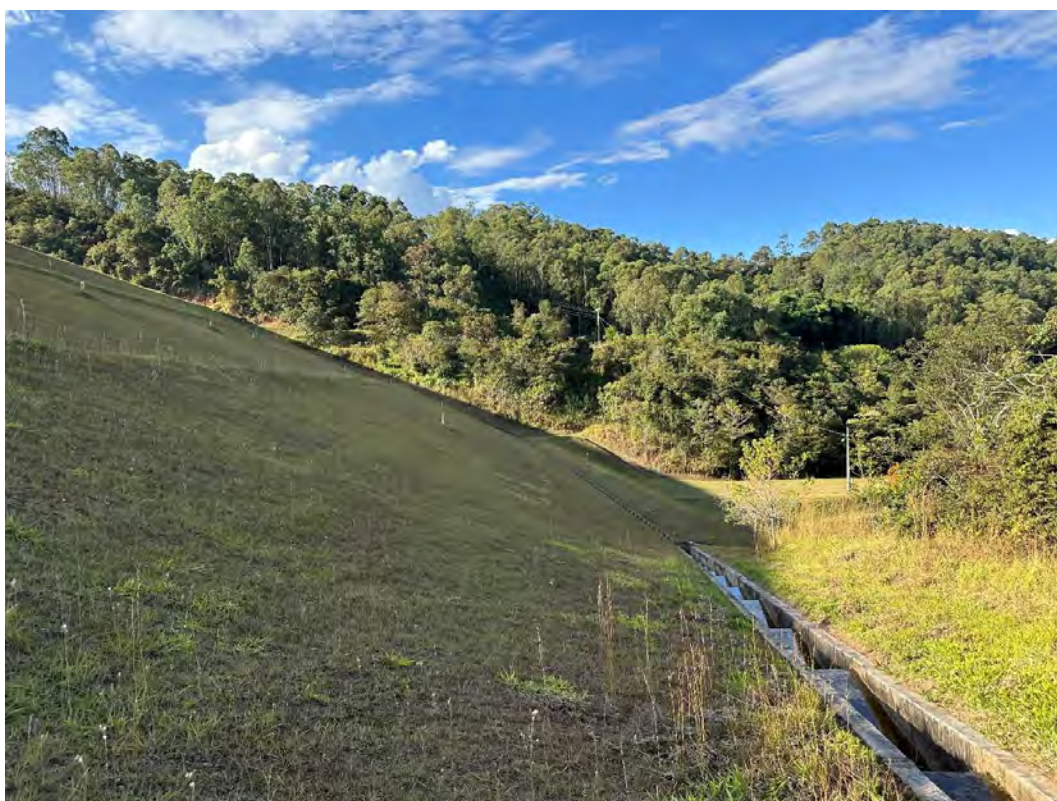
Foto 16 – Talude de jusante entre as cotas 955 e 965 m – Vista para a ombreira esquerda.
