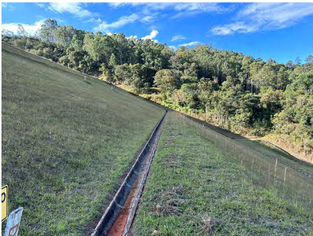
Foto 15 – Talude de jusante – Berma da cota 965 m – Vista para a ombreira esquerda.
