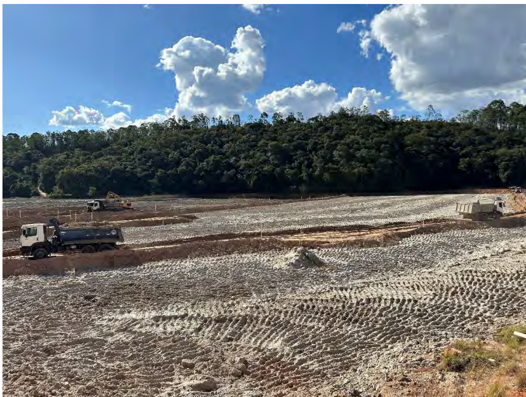
Foto 3 – Reservatório – Em andamento obras de escavação e aterro do reservatório para o projeto de descaracterização da barragem.
