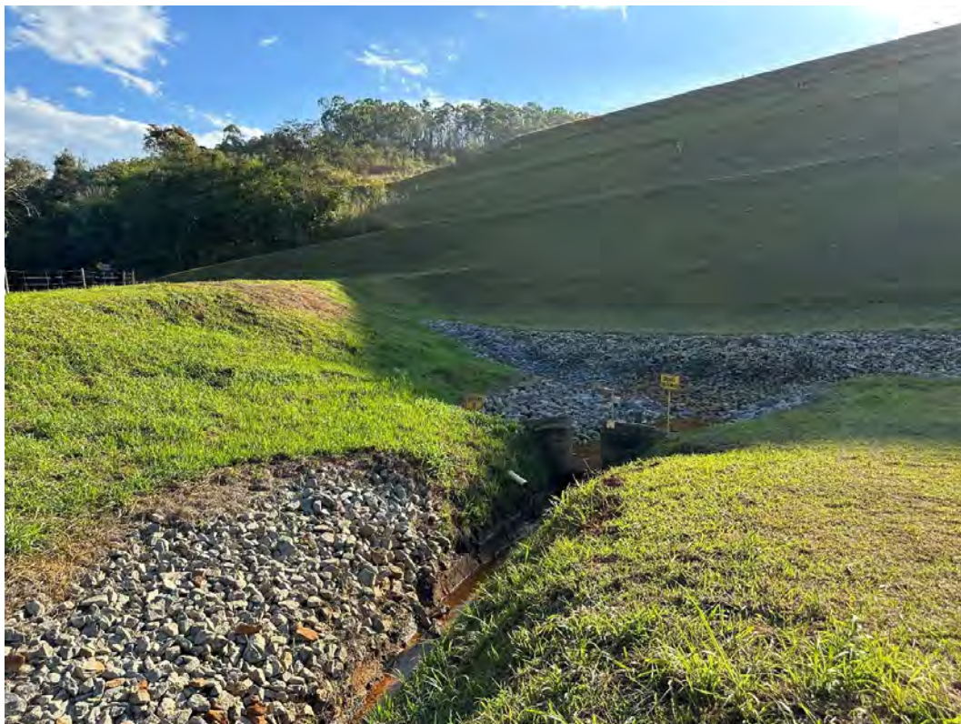
Foto 19 – Talude de jusante – Vista frontal.
