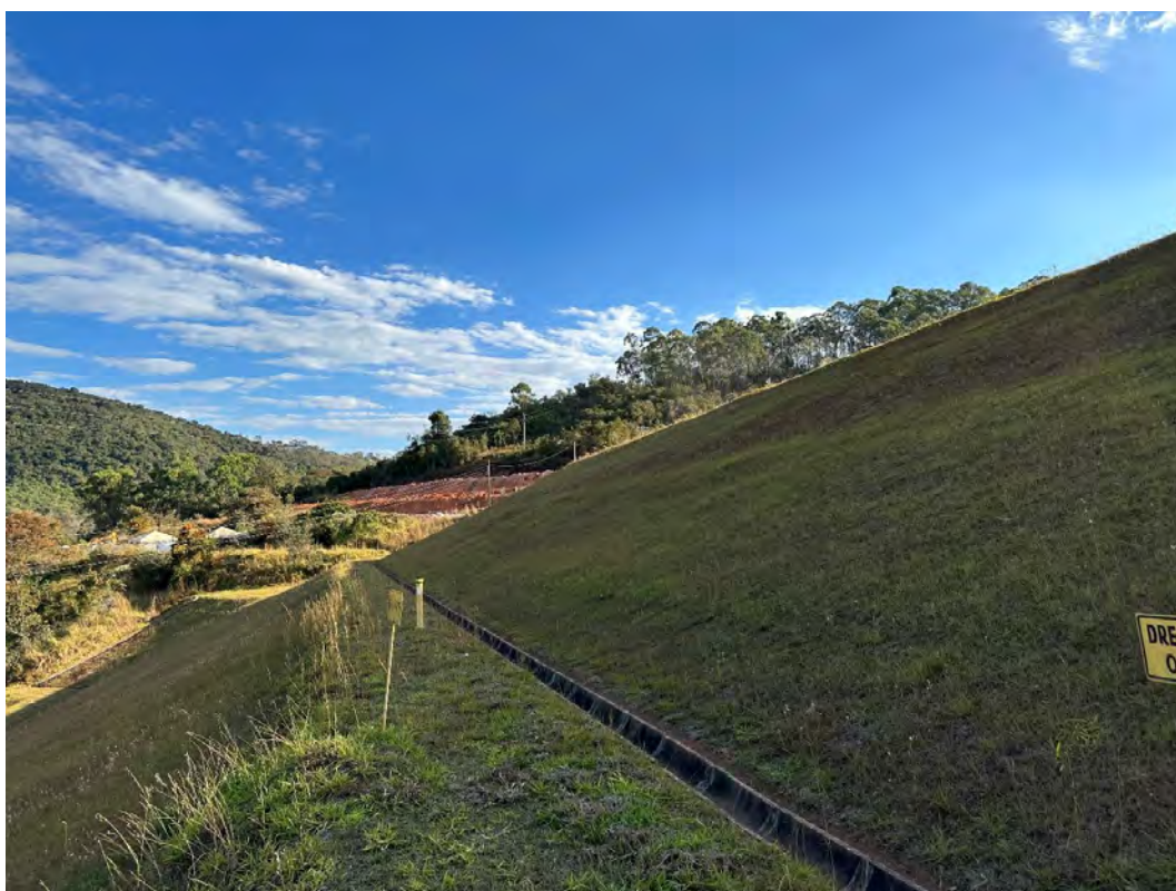
Foto 12 – Talude de jusante entre as cotas 975 e 985 m – Vista para a ombreira direita.
