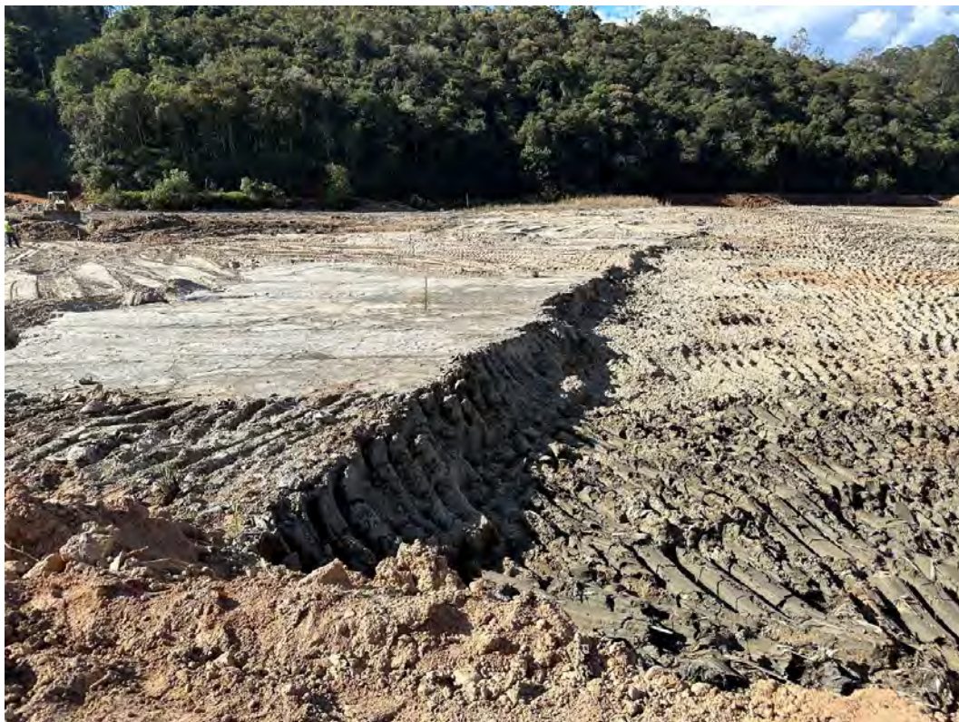
Foto 5 – Reservatório – Em andamento obras de escavação e aterro do reservatório para o projeto de descaracterização da barragem.
