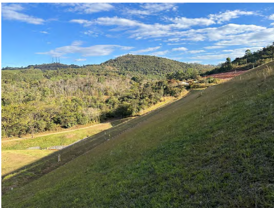
Foto 14 – Talude de jusante entre as cotas 965 e 975 m – Vista para a ombreira direita.
